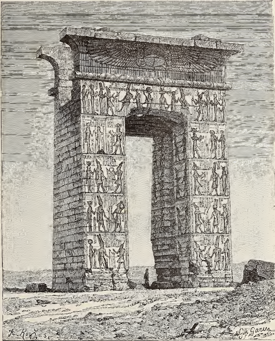
RUINES DE THÈBES. — PROPYLONE OU PORTE DU NORD.
